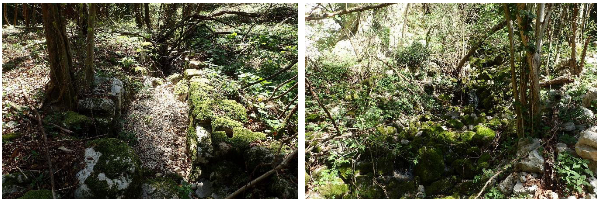
Figura 21 – Sponde in pietrame a secco a delimitare il sedime dell'alveo (sinistra); tratto in cui emerge l'acqua generando una discreta portata (destra).
