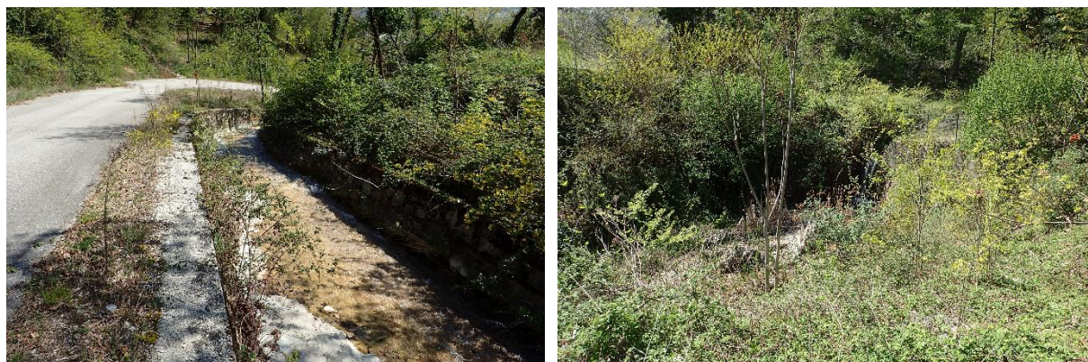
Figura 11 – Cunettone appena a valle dell'uscita del tratto vallivo (sinistra); bacino di deposito a monte della strada che conduce alla ex cava (destra).
