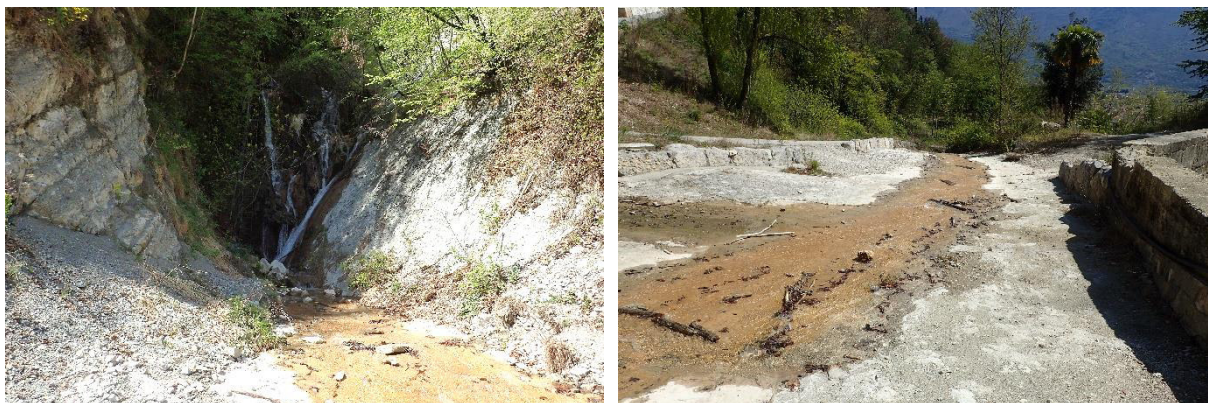
Figura 25 – Immissione del corso d'acqua in corrispondenza dell'area dell'ex cava (sinistra); inizio del cunettone con cui l'acqua è condotta a valle (destra).
