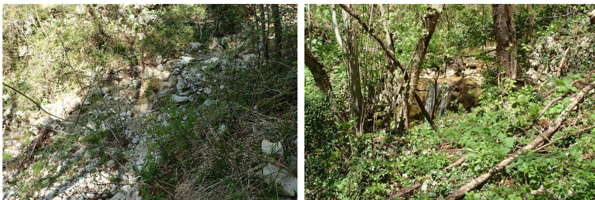
Figura 23 – Alveo con elementi lapidei disponibili al trasporto (sinistra); briglia in pietrame (destra).
