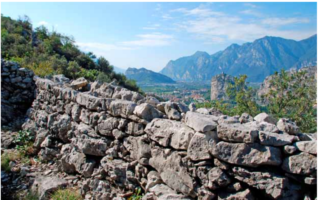
Dai muretti delle trincee valorizzate dal lavoro del Gruppo Alpini di Arco si ammira il panorama della parte occidentale del Basso Sarca.
