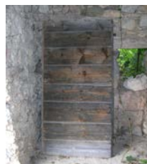
ESEMPI DI NUOVI SERRAMENTI INSERITI A CHIUSURA DI FORI CARATTERISTICI DELLE TIPOLOGIE ORIGINARIE: APERTURE FUNZIONALI ALLA VENTILAZIONE DEL SOTTOTETTO, IN ORIGINE SPESSO CHIUSE DA TAMPONAMENTI LIGNEI; APERTURE TIPICHE DELLE STRUTTURE ADIBITE A FIENILE
