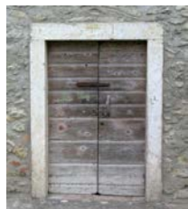
ESEMPI DI NUOVI SERRAMENTI INSERITI A CHIUSURA DI FORI CARATTERISTICI DELLE TIPOLOGIE ORIGINARIE: APERTURE FUNZIONALI ALLA VENTILAZIONE DEL SOTTOTETTO, IN ORIGINE SPESSO CHIUSE DA TAMPONAMENTI LIGNEI; APERTURE TIPICHE DELLE STRUTTURE ADIBITE A FIENILE
