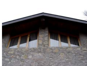
ESEMPI DI NUOVI SERRAMENTI INSERITI A CHIUSURA DI FORI CARATTERISTICI DELLE TIPOLOGIE ORIGINARIE: APERTURE FUNZIONALI ALLA VENTILAZIONE DEL SOTTOTETTO, IN ORIGINE SPESSO CHIUSE DA TAMPONAMENTI LIGNEI; APERTURE TIPICHE DELLE STRUTTURE ADIBITE A FIENILE
